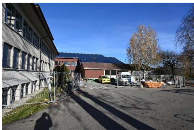
Schulhaus Gerzensee, Sanierung MZG 2024
