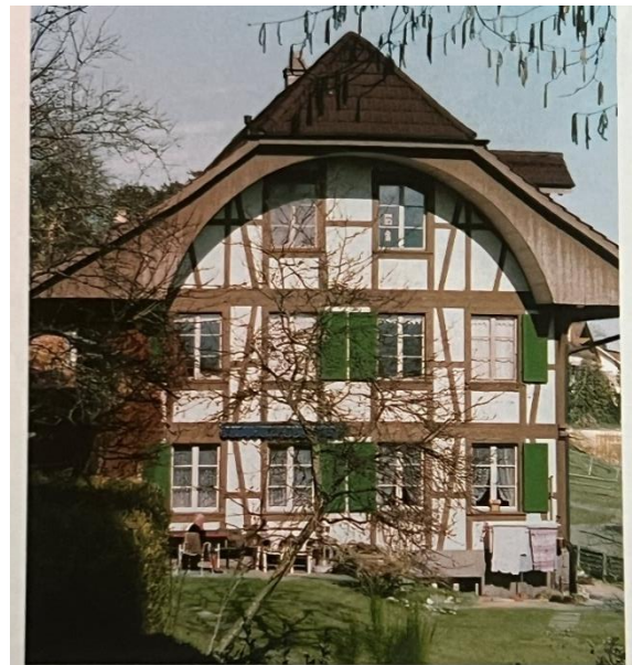
Das zweite Schulhaus, 1845 errichtet. Ab 1954 Lehrerhaus.
