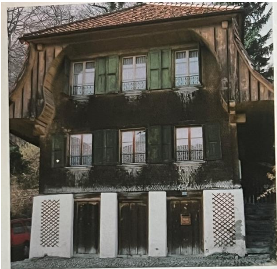
Das erste, um 1675 erbaute, einstöckige Schulhaus wurde 1824 aufgestockt und erhielt das Mansardendach. Ab 1850 Gärtnerhaus zum Rosengarten.
